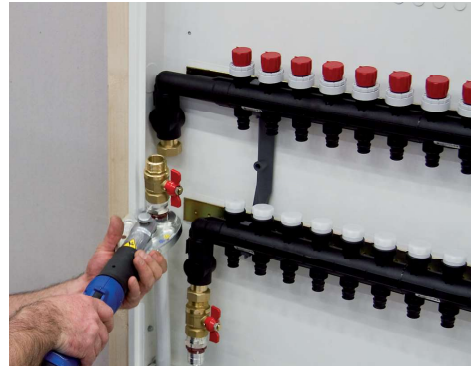
13. Montera matningsröret, i detta fall MLC-rör.
