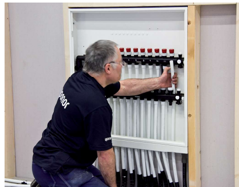
15. Markera noga rätt längd på golvvärmerören. Märk respektive slinga med rätt rumsbeteckning.
