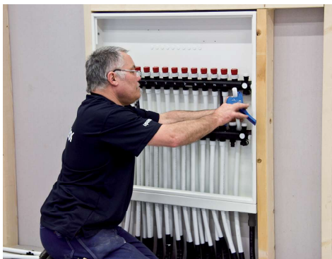
16. Kapa röret. Fortsätt installationen med anslutning av antingen Q&E eller EuroCone-koppling.
